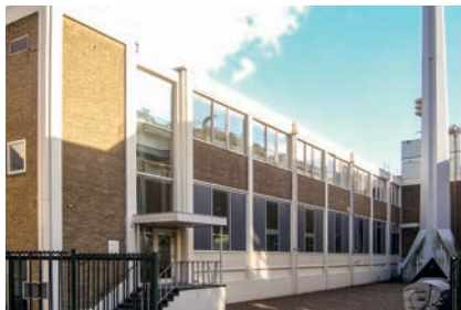
Districtcentrale Nieuwstraat/Bagijnenstraat, Deventer.
