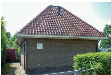
Eindcentrales met schilddak in Terwolde en Diepenveen.
