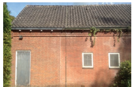
Oude eindcentrale met zadeldak in Twello.
