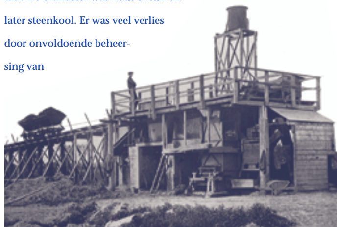
Een eempers- steenvormmachine met ophaalrooster en mengmachine van Aberson, Olst.
