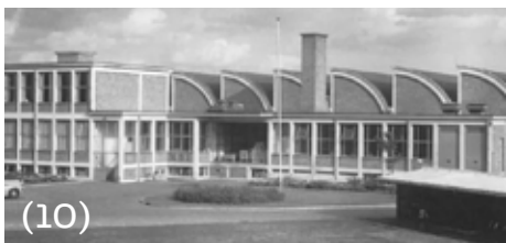
Op het lege terrein van Roto Smeets blijven nog enkele gebouwen behouden, waaronder het kenmerkende gebouw met de sheddaken.
