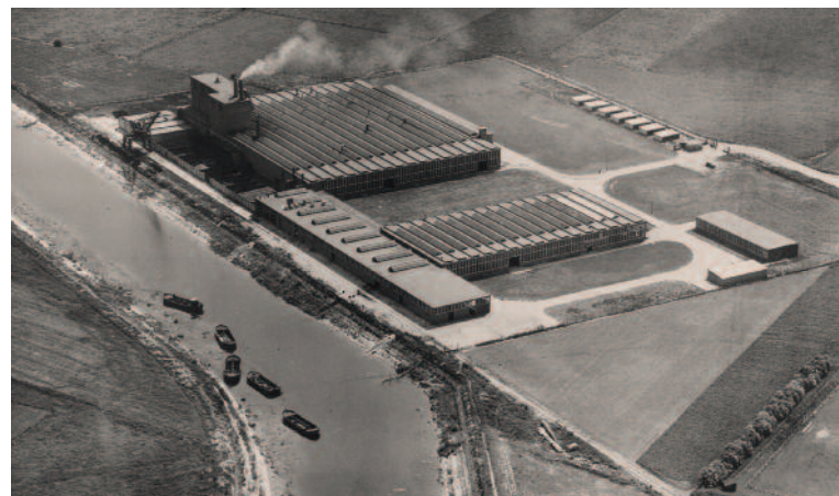
De nieuwe bedrijfsgebouwen begin jaren '50
