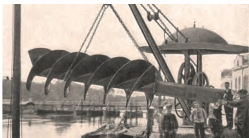
Watervijzel, 1m68 diam. aan de Welle. Cat. 1932.
