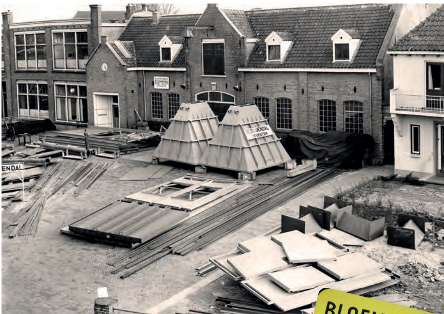
Machinefabriek Bloemendal. Na 1957. Links het gedeelde kantoor, rechts de (afgebroken) villa
