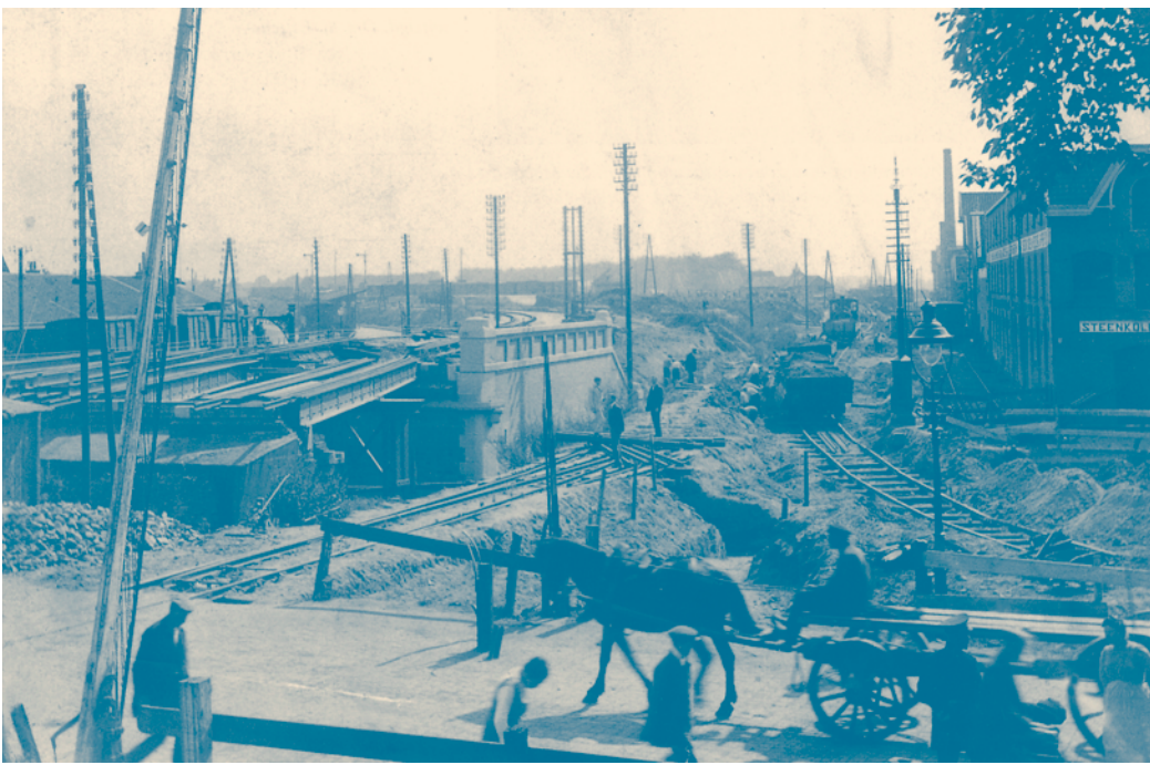
Aanleg viaduct Brinkgrevenweg, Ca 1918.
