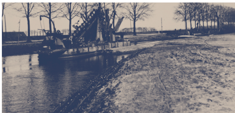
Aanleg ontleiding Overijssels Kanaal tussen Snijpelingsdijk en Hunneperkade rond 1920.
