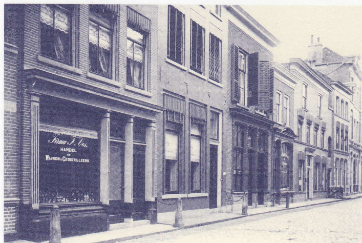
Electriciteits- en radiozaak van H. Bronkhorst, Nieuwstraat, 1914.
