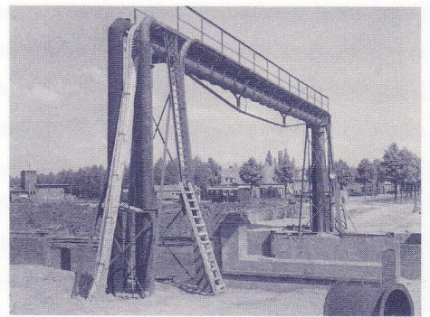
Nieuwe Haven. Noodleidingen gas, water en elektriciteit. 1948.
