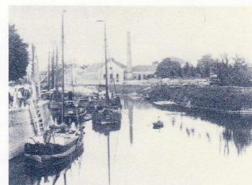
Haven met gasfabriek. Foto 1885.
