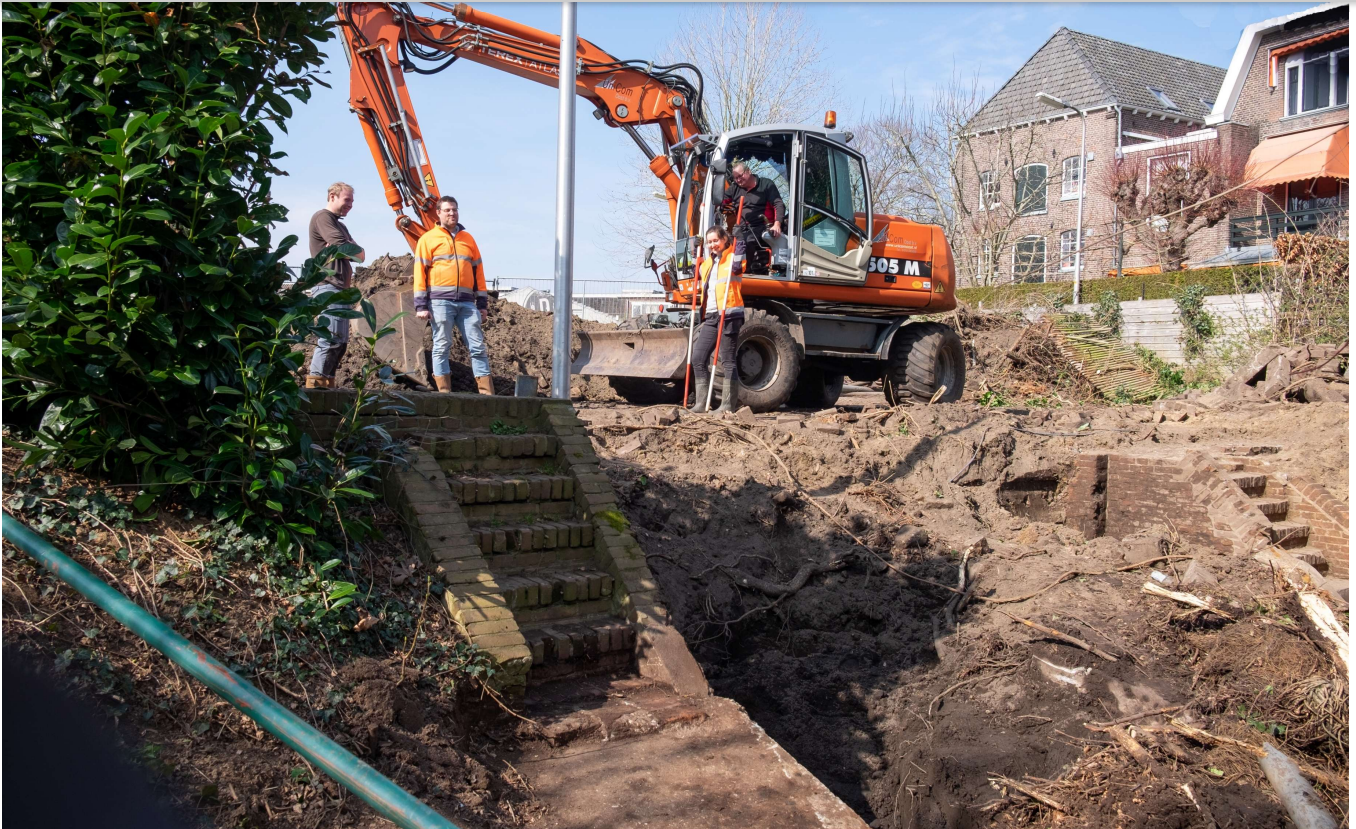
De Pothoofdsluis, één van de kandidaten voor de Erfgoedsterren prijs. En onze favoriet.
