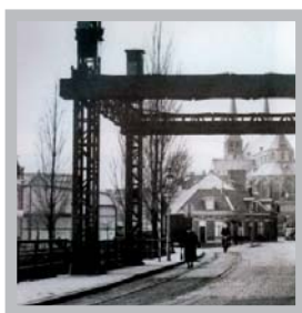
Onder: Kazernestraat met hefbrug over de Buitengracht (1926)
